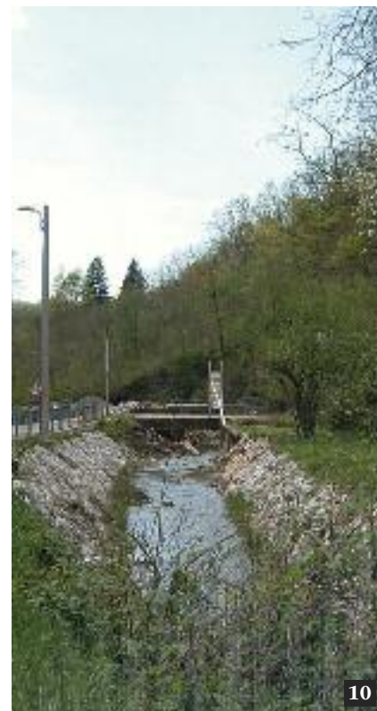
Torrente Groinizza. Località Scedina. Intervento della Protezione civile su alveo e sponde.
