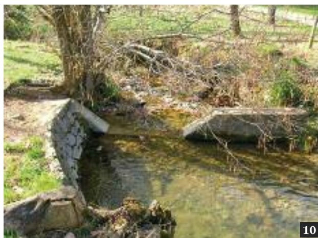
Sbocco del Potok Piuma sotto il maneggio La Remuda. Qui sono in progetto nuovi lavori di sistemazione dell'alveo a cura del Corpo Forestale.
