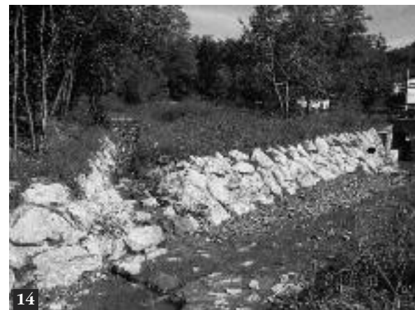
Fine dei lavori sul torrente Groinizza. Interventi a "scogliera" su alveo e sponde.
