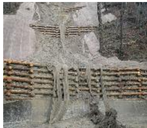
Messa in sicurezza, con "palificata", di un versante di frana lungo la strada di Costabona. 2005, Protezione Civile del Friuli Venezia Giulia.
